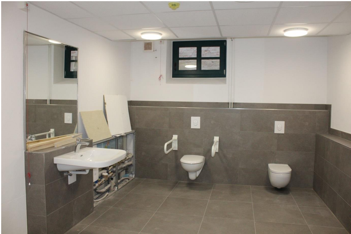
Das neue barrierefreie WC im Groot Hus ist fast fertiggestellt. Zusammen mit Kinder-WC und Wickelbereich ist es auch komfortabel für Familien mit Kleinkindern eingerichtet.
